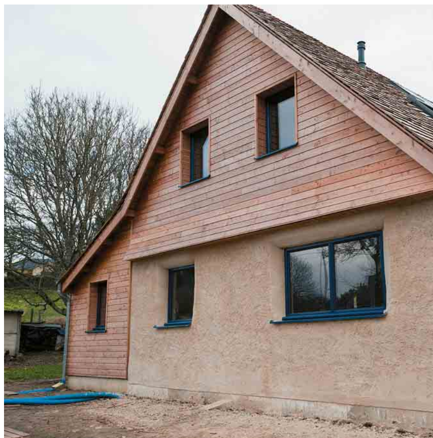
La maison que construit Robin Gobet à Binic. Une fois appliqués les enduits, on ne voit plus la paille.
